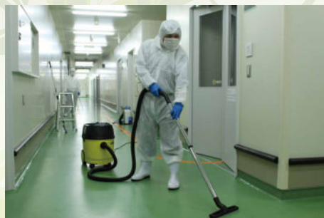
● 乾湿両用掃除機による薬液回収
